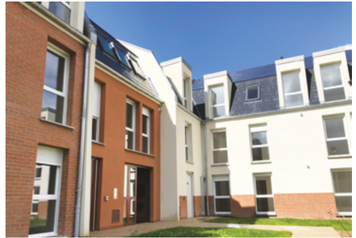
La résidence intergénérationnelle à Pont-de-Metz
