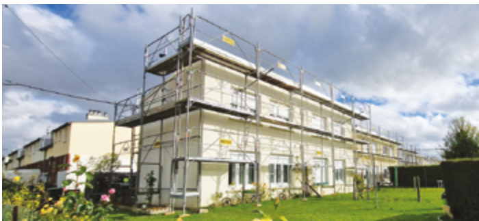
Lancement de la réhabilitation de 102 logements à Corbie
