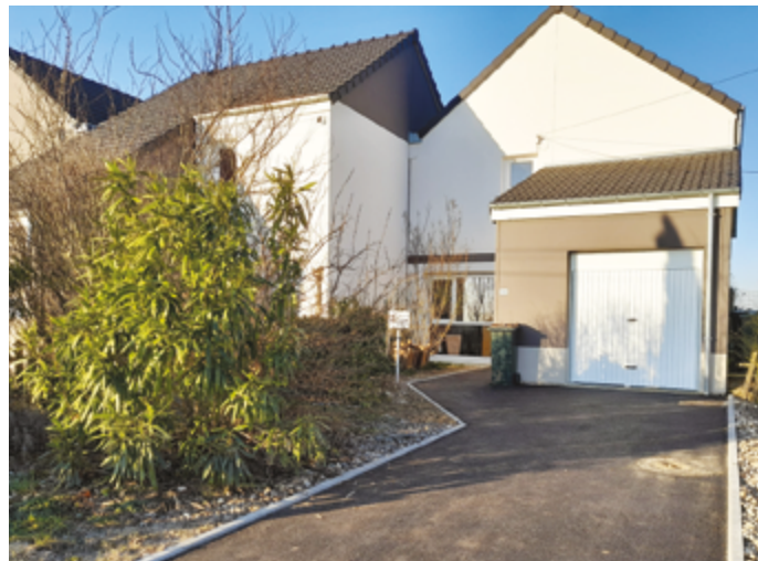
15 logements individuels ont été réhabilités à Assevillers
